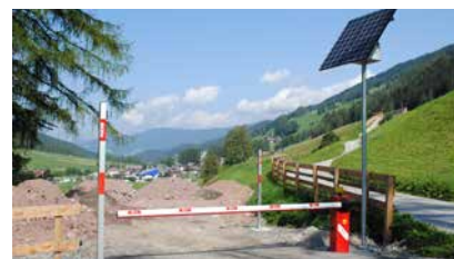
Bauschuttanlage Gemeinde [Sexten]
